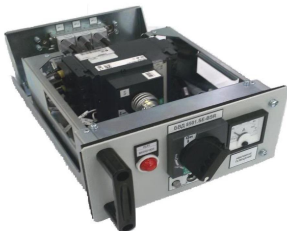
Рисунок 6.2 – Выдвижной блок
