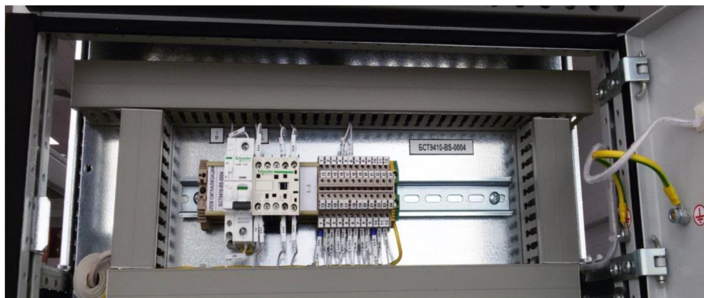
Рисунок 4.5 – Отсек общих шин
