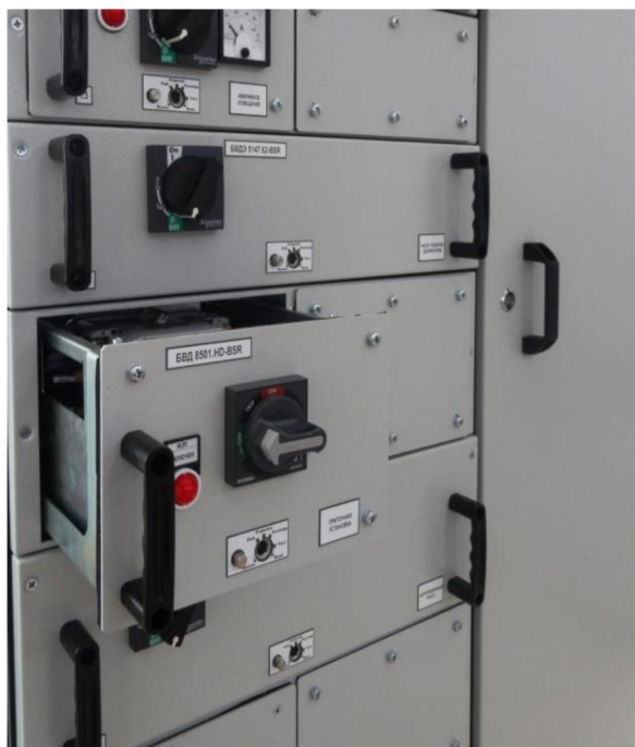
Рисунок 4.6 – Отсек функциональных блоков
