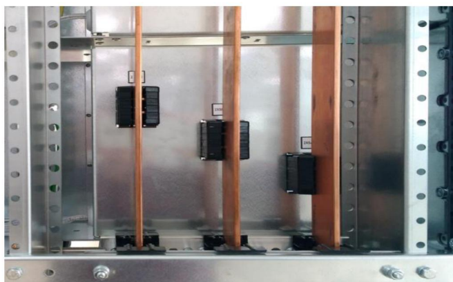
Рисунок 4.4 – Отсек вертикальных распределительных шин
